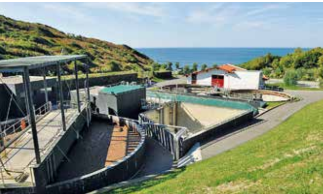
Station d'épuration à Guéthary. L'assainissement est une clé de l'avenir.
