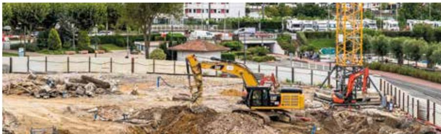
Le chantier de construction du parking a redémarré fin août. L'entreprise Eiffage, pour le compte d'Indigo, procède à l'évacuation de la terre située à l'intérieur de la paroi moulée. L'excavation sera conduite progressivement, par plateaux successifs, avec la pose des poutres transversales permettant d'assurer le soutènement de la paroi moulée au fur et à mesure de l'avancement des opérations.
